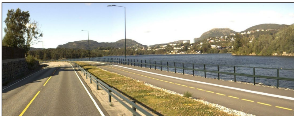
Bilde 2: Fv. 574 Bjørgeveien i Bergen – sykkelveg med fortau
